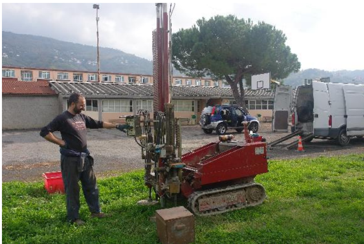
FOTO n.10 prova penetrometrica statica CPT n.2
