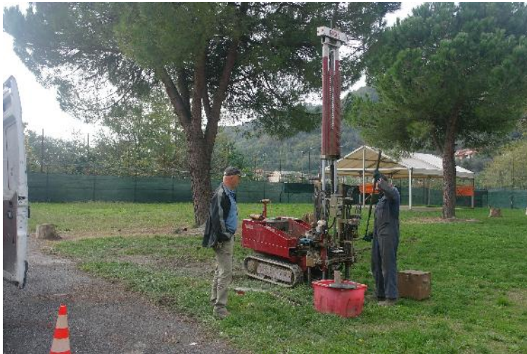
FOTO n.9 prova penetrometrica statica CPT n.1
