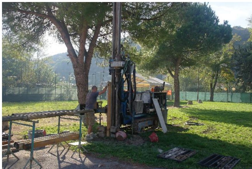
FOTO n.6 sondaggio geognostico - posa rivestimento
