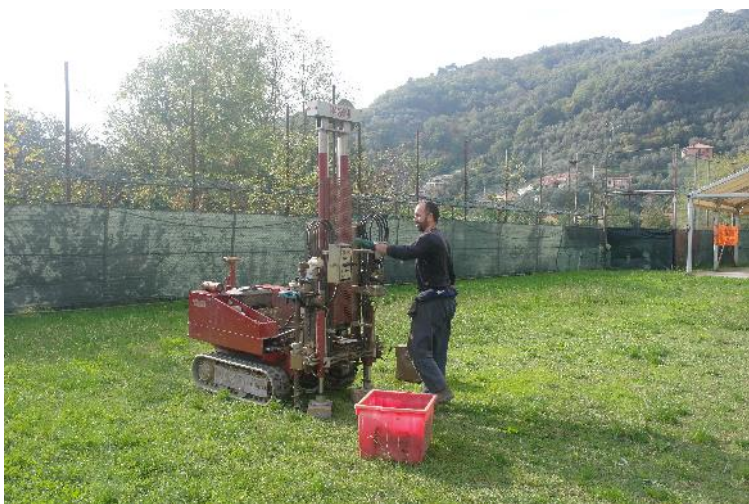
FOTO n.11 prova penetrometrica statica CPT n.3
