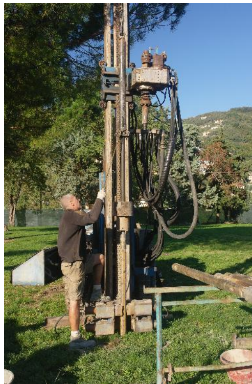
FOTO n.7 sondaggio geognostico prova SPT
