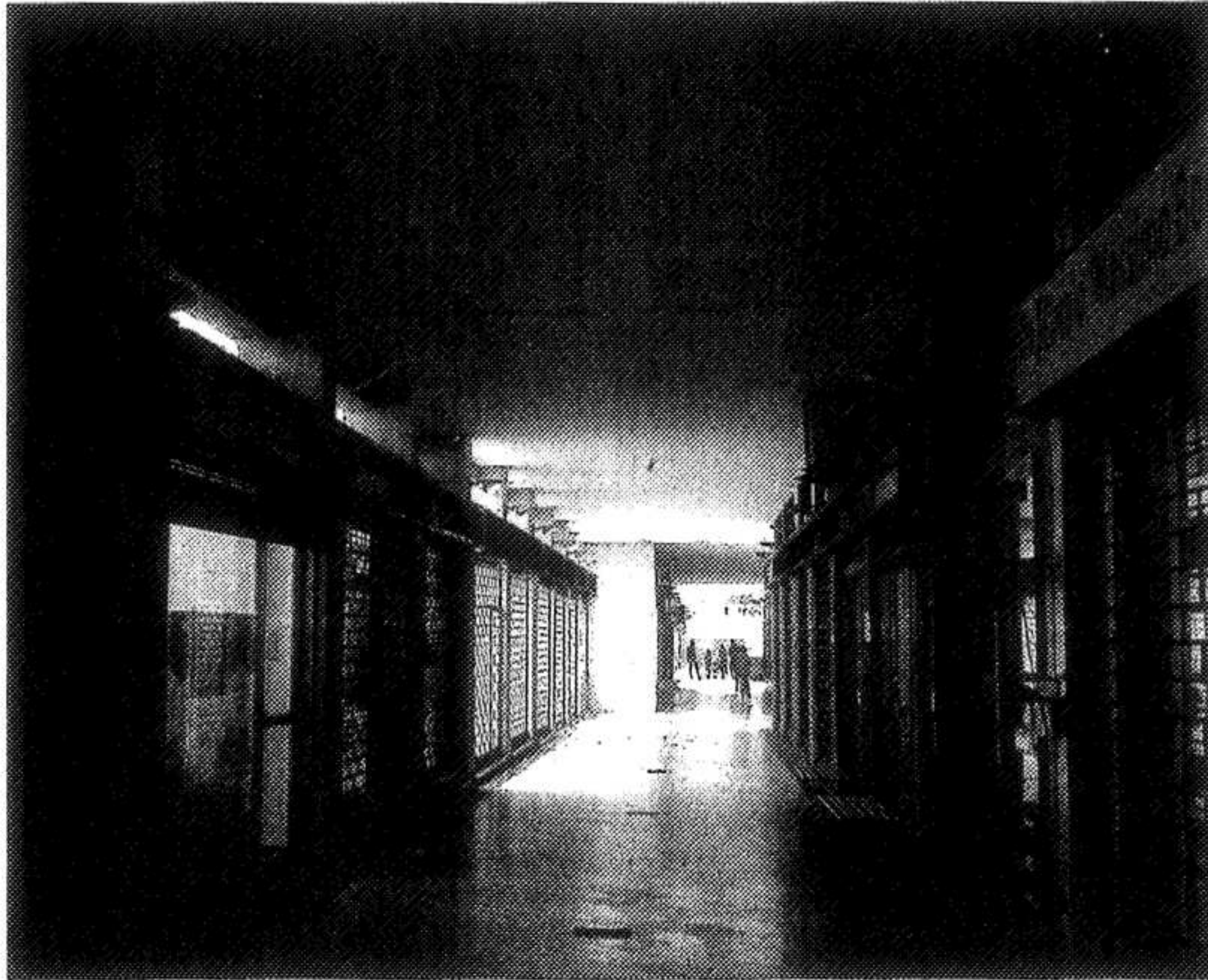
La galleria pedonale di via Cavour a Lavagna
