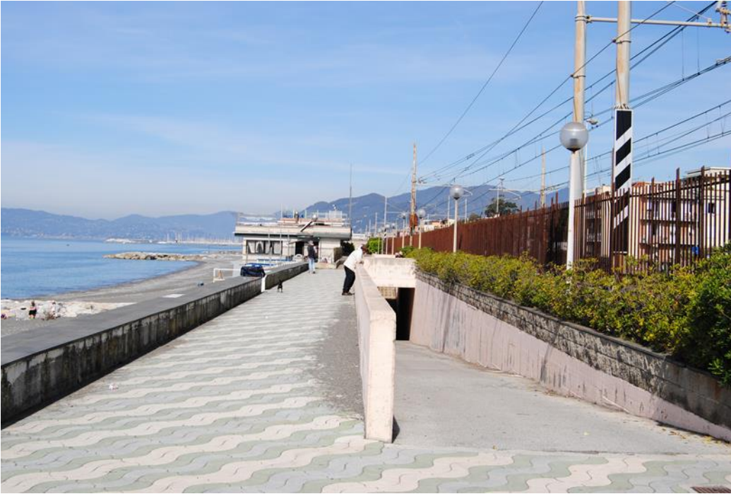
F6_Percorrendo la passeggiata a mare - accesso al sottopasso
