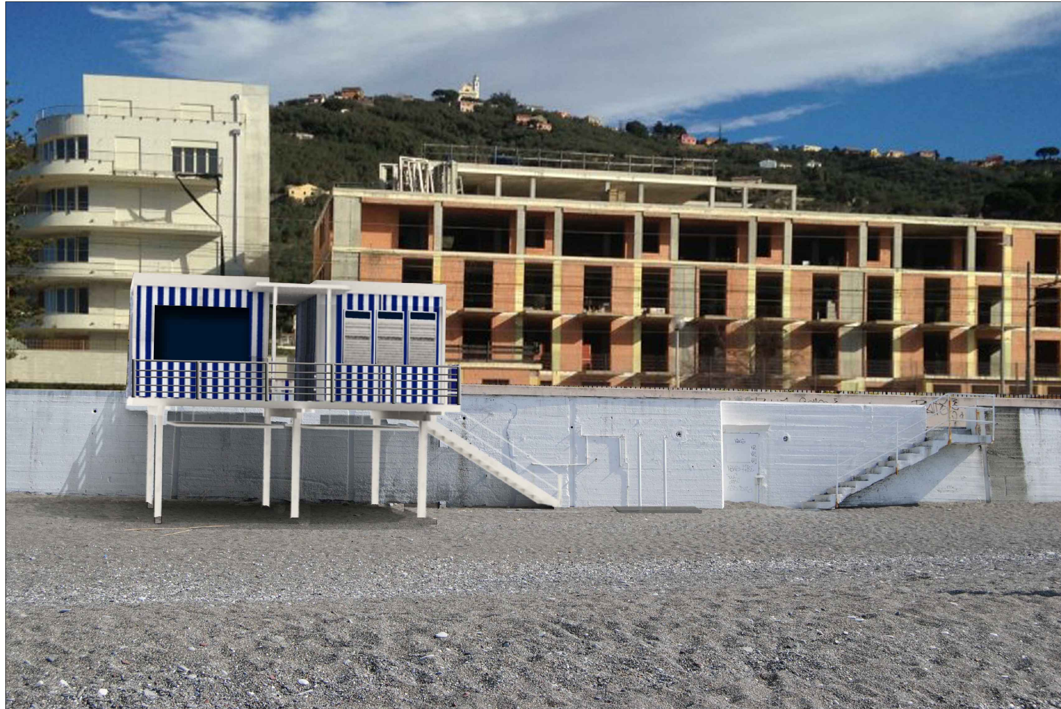
Vista frontale lato spiaggia
