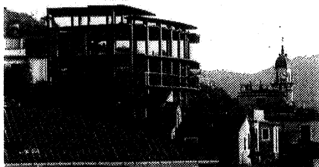
L'ecomostro di Cavi di Lavagna
