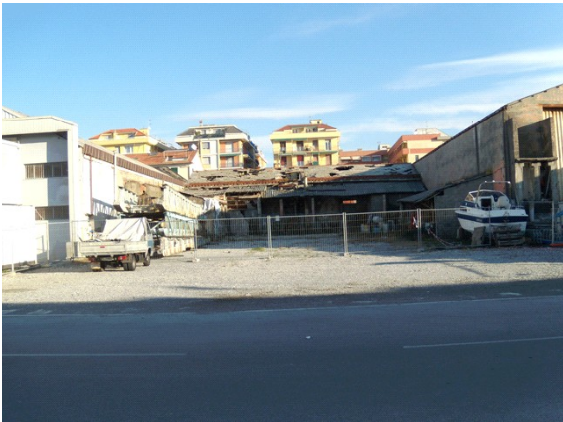
Viste del prospetto sui piazzali del porto
