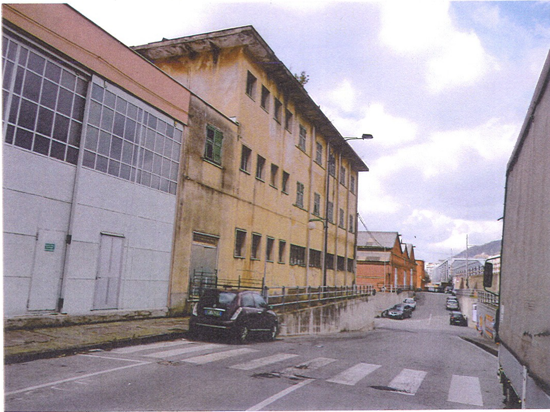
Vista del prospetto da Via dei Devoto verso ovest
