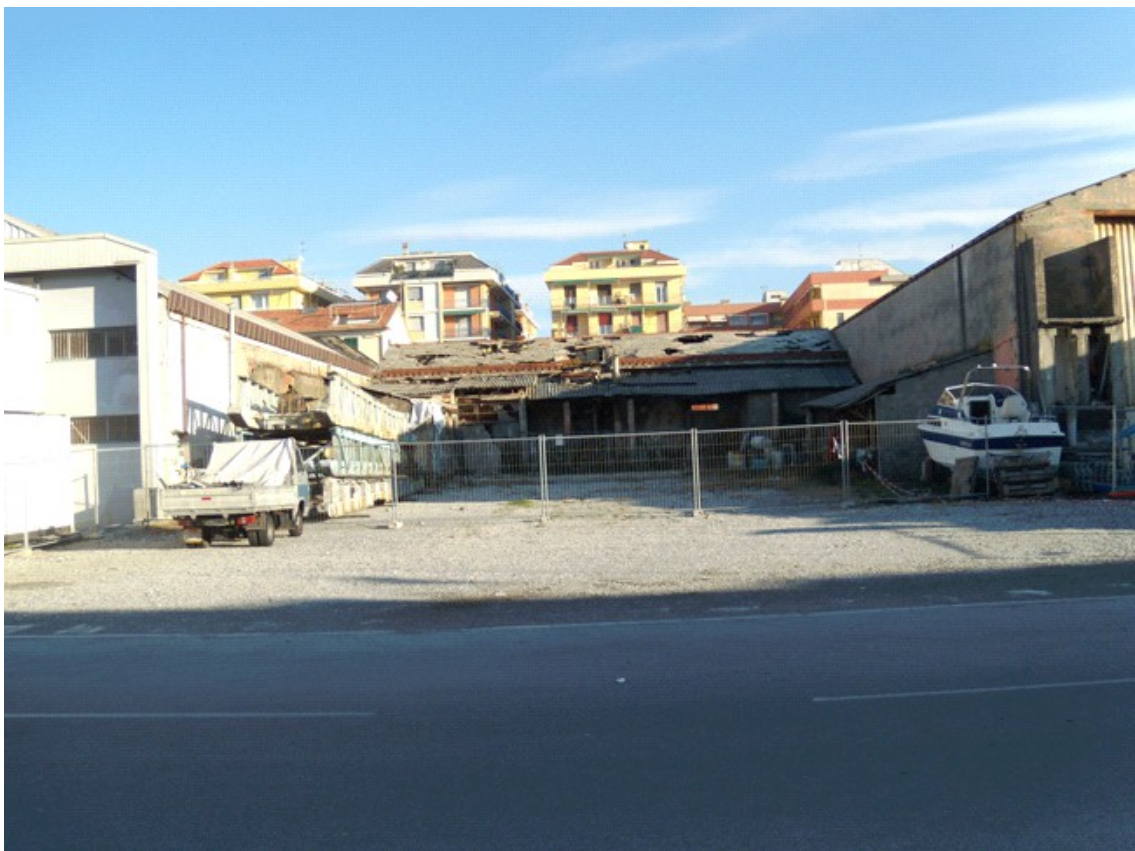
Viste del prospetto sui piazzali del porto
